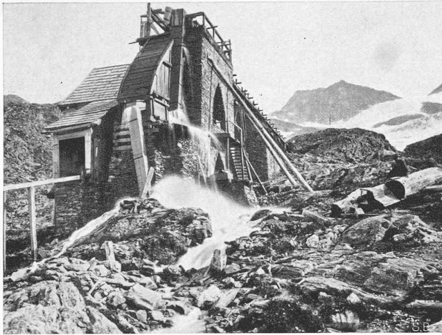
Abb. 1. Altes Radhaus 2177 m ü. M., Oberstation mit Wasserrad-Antrieb der Hanfseilbahn nach Kolm Saigurn hinunter
