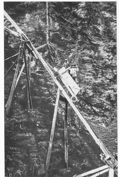
Abb. 2. Alte Hanfseil-Bahn von Kolm Saigurn (1597 m ü. M.) nach dem Radhaus (Abb. 1) mit Holz-Schienen und -Rädern
