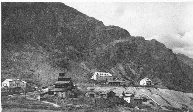
Abb. 14. Die heutigen Bergbauanlagen im Nassfeld beim (nicht sichtbaren) Valeriahäus
