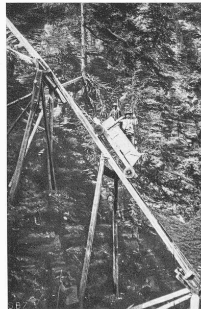
Abb. 2. Alte Hanfseil-Bahn von Kolm Saigurn (1597 m ü. M.) nach dem Radhaus (Abb. 1) mit Holz-Schienen und -Rädern
