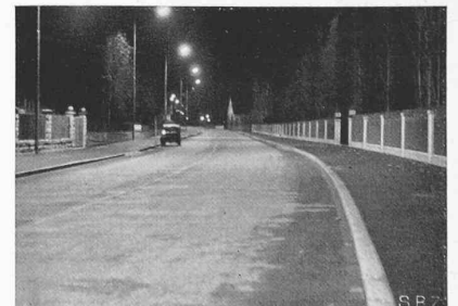
Abb. 2 (rechts) Zürichseestrasse bei Meilen mit «Philora»-Natrium- dampflampen SO 650
