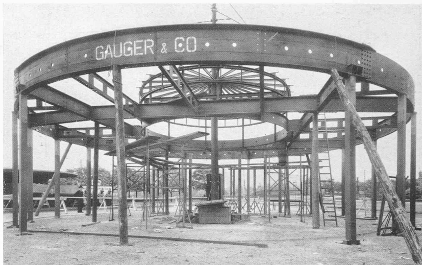
Abb. 3. Die mittleren Ringstützen, Bauzustand am 4. Oktober 1937
