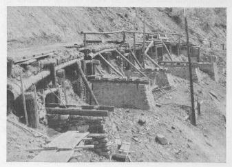
Abb. 11. Neue Fundamente des Lehnenviadukts Magnacun
