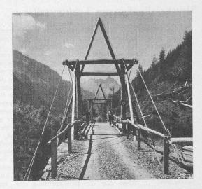
Abb. 16. Hängebrücke in Holzbau, erbaut von Prader & Co. (Chur), als Hilfsbrücke anstelle der zerstörten eisernen im Safiertal
