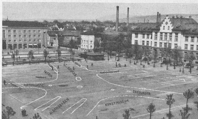
Geplante Verkehrsführung Wettsteinbrücke-Albangraben und -Dufourstrasse in Basel, auf dem Mustermessplatz in Naturgrösse aufgemalt zur Erprobung ihrer Zweckmässigkeit und allfälliger Aenderungen
