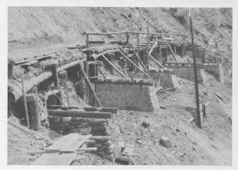
Abb. 11. Neue Fundamente des Lehnenviadukts Magnacun
