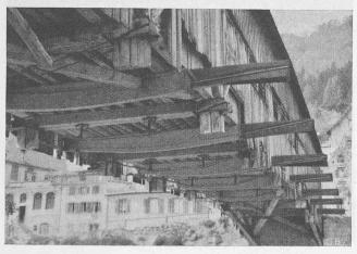
Abb. 1. Auskragende Hetzerträger für den Gehsteg
