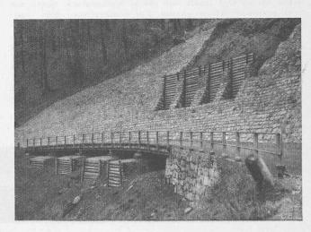
Abb. 12. Neuer Lehnenviadukt bei Magnacun unterhalb Guarda im Unterengadin; Futtermauern und Steinfang
