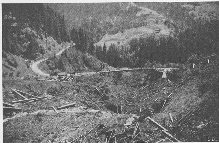
Abb. 16. Hängebrücke in Holzbau, erbaut von Prader &amp; Co. (Chur), als Hilfsbrücke anstelle der zerstörten eisernen im Safiortal
