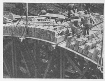
Abb. 6. Gewölbemauerung der neuen zweiten Viamalabrücke
