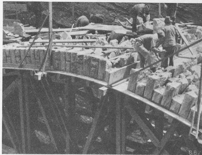
Abb. 6. Gewölbemauerei der neuen zweiten Viamalabrücke
