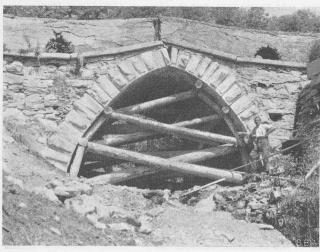
Abb. 4. Durch einseitigen Schub zerstörte Brücke im Val Gronda
