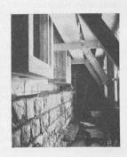
Abb. 14. Betonierte Fenstergewände und Vormauerung
