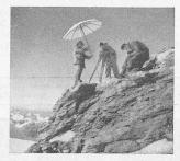
Abb. 7. Sphinxgipfel gegen Mönch Abb. 8. Triangulation des obern Axpunktes des Schachtes zur Bestimmung seines Fusspunktes
