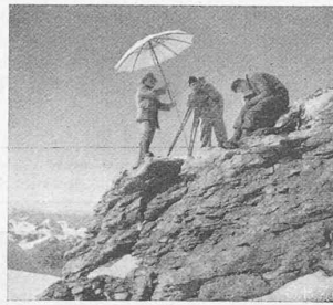
Abb. 8. Triangulation des obern Axpunktes des Schachtes zur Bestimmung seines Fusspunktes
