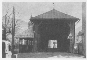
Abb. 2. Durchblick mit flussabwärts angebautem Gehsteg
