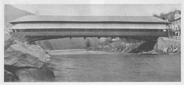
Abb. 3. Alte Holzbrücke über den Vorderrhein bei Ilanz mit einseitig vorkragend angebautem Gehsteg
