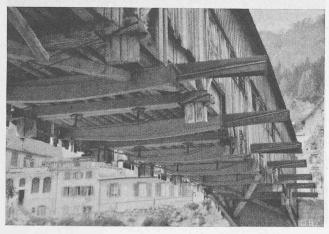
Abb. 1. Auskragende Hetzerträger für den Gehsteg
