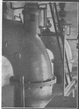
Vertikal-Propellerpumpe 30 000 lit/min
