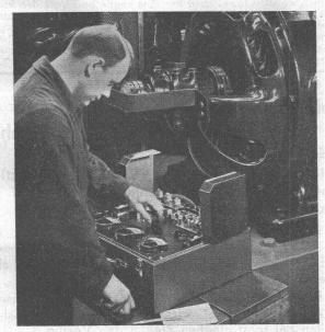
Z-Messkoffer für Wechselstrom-Leistungsmessungen bei der Ueberprüfung einer Maschine
