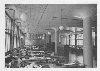
Abb. 15. Grosser Bureauraum, Celotexplatten zu Einzelflächen zusammengefasst (nachträglich angebracht, ungünstiger als Abb. 12)
