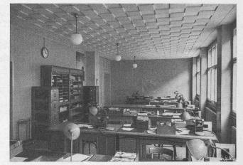
Abb. 12. Bureauraum 370 m³, Decke gedämpft durch Celotexplatten in Schachbrettanordnung
