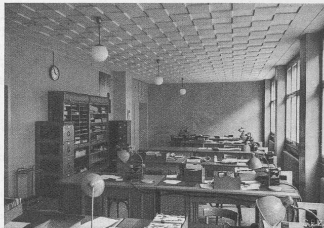
Abb. 12. Büreauraum 370 m 3 , Decke gedämpft durch Celotexplatten in Schachbrettanordnung
