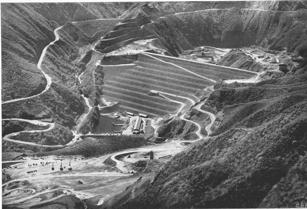
Abb. 6. Der vollendete Damm von der Luftseite, Juli 1937. Aushub des Entlastungs-Ueberfalls Im Vordergrund der Steinbruch
