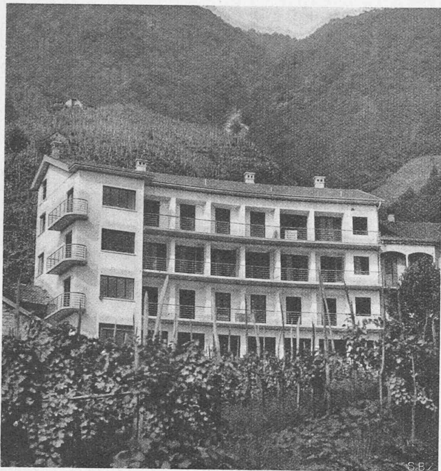
Abb. 2. Altersheim Gordola, Südansicht. Arch. G. FERRINI
