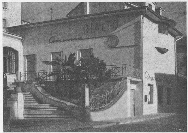
Abb. 12. Der umgebaute Kino Rialto in Muralto Rechts oben Projektionskabine, im Kreis Ventilationsöffnung
