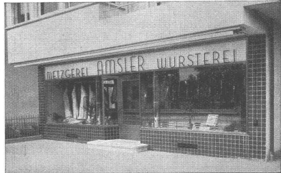
Schaufensteranlage inkl. Metalltüre sowie Bronzeschrift montiert vor durchleuchtetem Opalüberfangglas.
