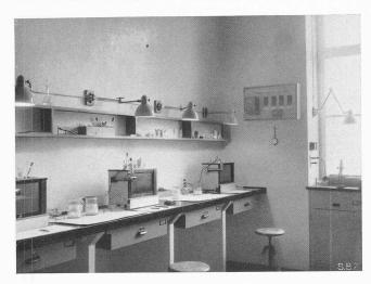
Abb. 1. Hochempfindliche Mikrowaagen (± 1 Millionstel Gramm)
