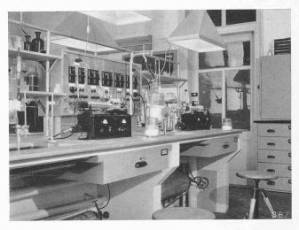
Abb. 2. Wärmeentwickelnde Apparate mit leuchtenden Absaugehauben
