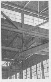
Abb. 8. Axe 2, Blick gegen Axe 3, Kranbahnaufhängung. Der schräg auf den Binder zulaufende grosse Träger bildet das Ende der Kranbahn der Hauptzulage
