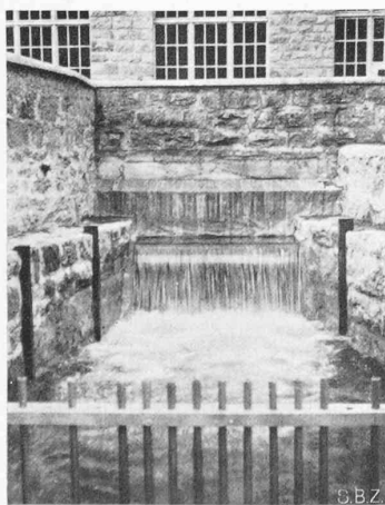
Abb. 7. Wasserschleier zur Absperrung des Turbinenlärms im Ablaufkanal (Kraftwerke Tremorgio und Küblis)
