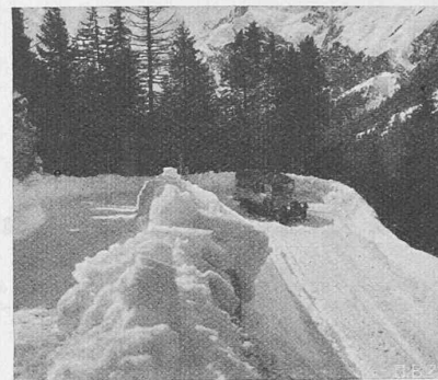
Abb. 9. Kehre Nr. 4 der Malojastrasse, Aussen-Durchmesser 22 m.
