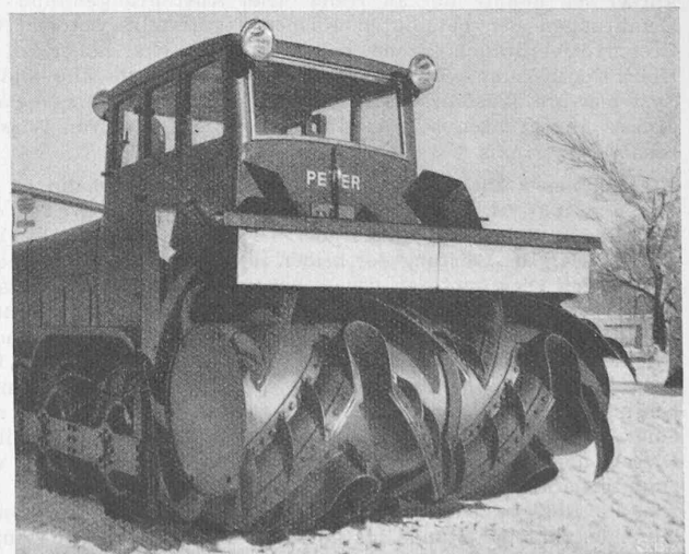
Abb. 6. Vorderansicht der Schleuderwalzen.
