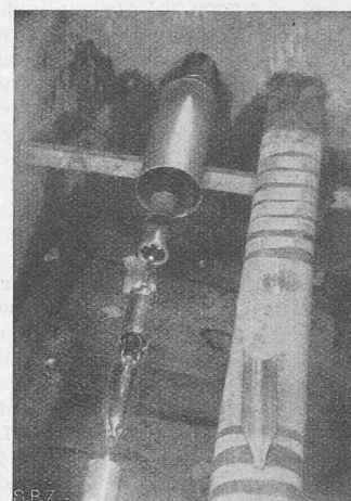
Abb. 3. Stromwandlermuffe in Montage und Abb. 4 fertig (geöffnet).
