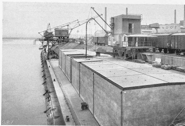
Abb. 14. Teilansicht der Getreidebehälter mit Förderanlage.
