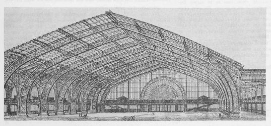
Abb. 9. Weltausstellung Paris 1889. Maschinenhalle auf dem Marsfeld, Stützweite 110,6 m (Nach «SBZ» 14. Sept. 89).
