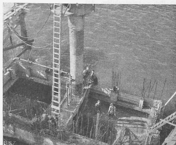
Abb. 12. Caisson der Wasserfassung nach dem Einschwimmen; Ebbe.
