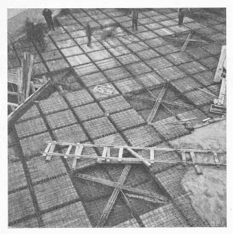
Abb. 1. Durchlaufende Eisenbetondecke eines Fabrikgebäudes. Stützenabstand 6 bis 9 m. Die zu den Umfassungsmauern parallel laufenden Kragträger über den Stützen bilden die Auflager für die Eckund Zwischenbalken. Die Stützenfelder werden voll ausbetoniert. Verglichene Betonstärke 10 cm, Balken 12 × 25 cm, Rundeisenbedarf 11 kg/m²
