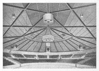
Abb. 5 und 6. Geschweisstes Hallendach für eine Kunsteisbahn in Blackpool (Lancashire), Spannweite 40.5 auf 46 m Rostbalken INP 45, Eisenbedarf 32 kg/m² inklusive Pfetten und Randbalken
