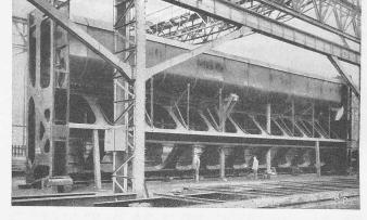
Stoney-Schütze mit aufgesetzter Stauklappe der Anlage Ramet-Ivoz.
