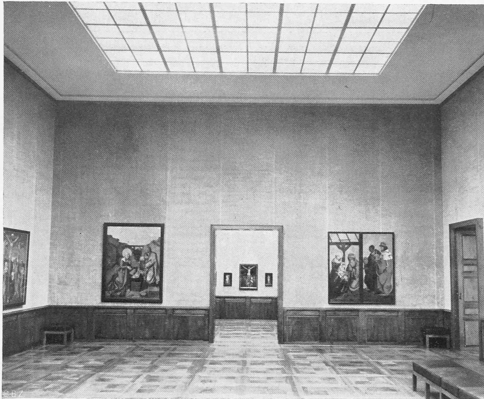
Abb. 11. Grosser Holbein-Saal, Durchblick zum westlichen Kabinett. Laternen-Oberlicht und Thermolux-Glasdecke. Wände grau-beige Leinensamt; Sockel, Türen und Parkettboden Nussbaum.
