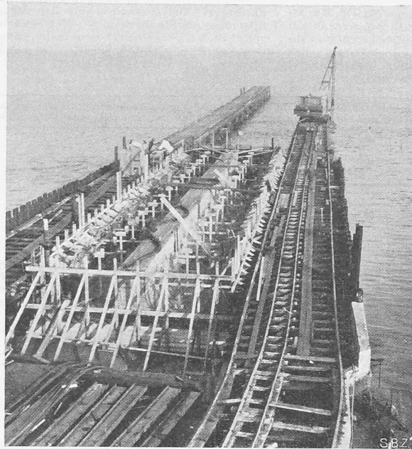
Abb. 6. Bau des ersten (Dock-)Caisson zwischen Spundwänden.
