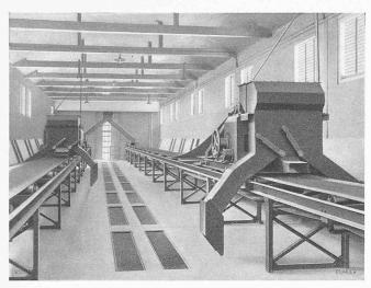
Abb. 5. Bandförderer mit Abwurfwagen über den Silozellen
