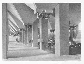
Abb. 6. Blick ins Erdgeschoss mit den Zellen-Ausläufen
