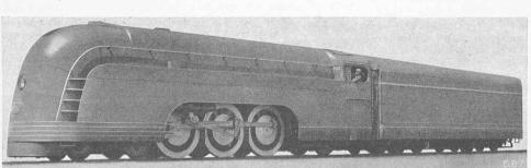
Abb. 2. Stromlinienförmig umgebaute «Mercury» K5 Pacific Lokomotive der N. Y. C.-Rd.
