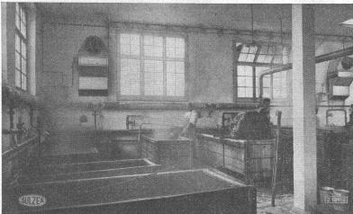
Gleiche Färberei mit Entnebelungsanlage in Betrieb, während des Aufheizens und Kochens der Bäder: Freie Sicht, ungehinderte Verkehrsmöglichkeit und gute Luftverhältnisse im Lokal bei geringstem Kostenaufwand.
