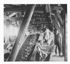
Abb. 18. Sortierband in der Verladeanlage
