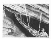
Abb. 12. Schüttelrutsche im Abbau vergl. Abb. 11, am Nordwestrand und im Bremsberg D
