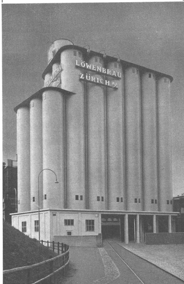
Silo-Anlage von 4500 m 3 Inhalt
