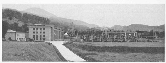
Abb. 4. Maschinenhaus mit Freiluft-Transformatorenanlage von 10 kV auf 16 u. 66 (SBB) und 150 kV (NOK)
