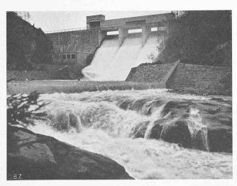
Abb. 3. Die Staumauer, Höhe über Talboden 27 m
