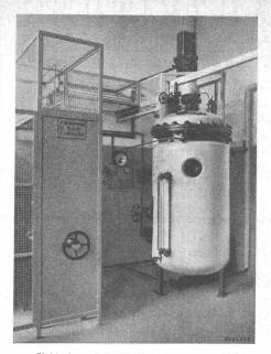
Elektrokessel für Wechselstrom 8000 Volt.
