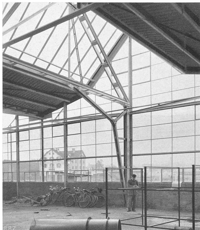
Abb. 25. Eisenkonstruktion der Halle: Binder, Pfosten, Eternitdach und Oberlicht, horizontale Sprengwerke zur Aufnahme des Winddruckes auf die Glaswand
