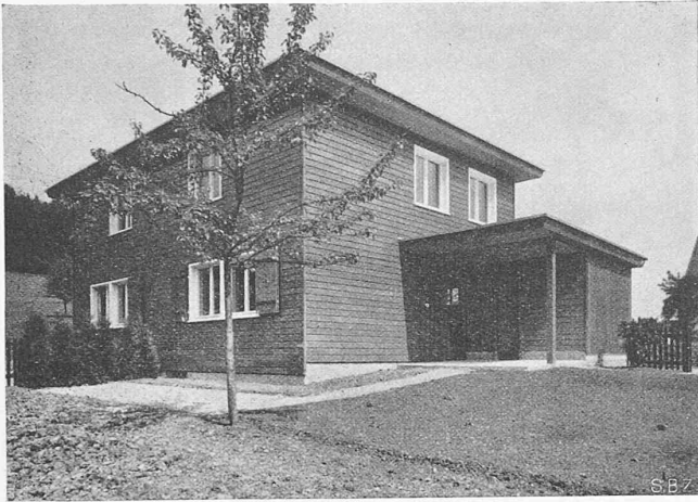
Abb. 3. Kleinhaus in Holzbauweise, Typ B, aus Südost
