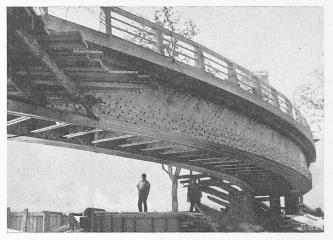
Abb. 1. Kurvenbrücke von 40 m Radius und 35 m Spannweite
