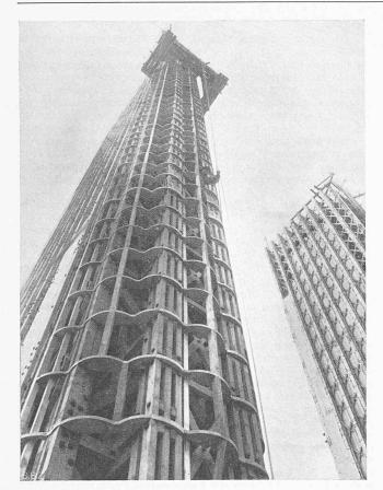
Abb. 7. Innenkonstruktion der 51 m hohen Türme, Grundfläche  $3\times10$  m
