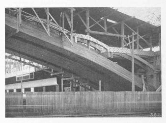
Abb. 6. Gewölbe von 65 m Stützweite, aus vernagelten Brettern
