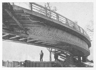
Abb. 1. Kurvenbrücke von 40 m Radius und 35 m Spannweite
