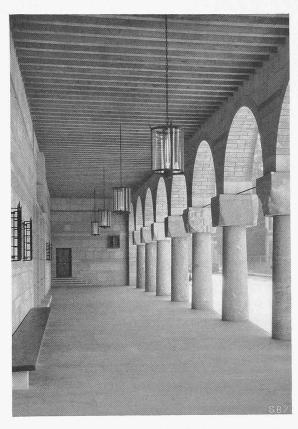
Arkade am Albangraben. – Säulen Tessinergranit (Kapitäle unfertig), Mauerfläche Kalkstein u. Granitbänder, Decke Eisenbetonbalken
