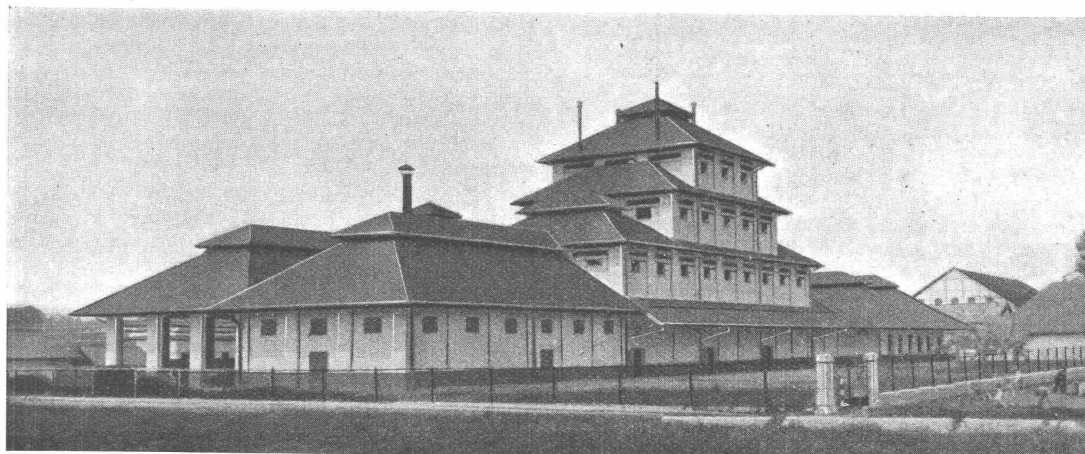
Brauereianlage in Soerabaja, Java. Gebäulichkeiten: Schwebende Pfahlfundierung mit 500 Eisenbetonpfählen, Eisenbetonrost, Skelettbau in Eisenbeton, eiserne Dächer mit Ziegelabdeckung, Ausmauerung mit Backsteinen. Text dazu siehe Seite 30.
