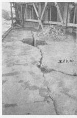
Abb. 5. Befund der Mauer nach Abheben der Bleiabdeckung
