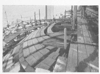
Abb. 15. Auflegen der Deckplatten auf einer Halbkuppel
