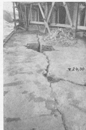
Abb. 5. Befund der Mauer nach Abheben der Bleiabdeckung
