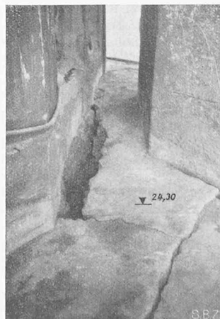
Abb. 5. Befund der Mauer nach Abheben der Bleiabdeckung
