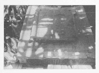
Abb. 7. Pfeilerkern mit späterer Ummantelung, beim Abbruch
