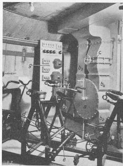
Abb. 16. Teilansicht eines Maschinenraumes für eine Lüftungsanlage mit Filter. a Vierwegklappe, b die vier einmündenden Lüftwege, c gasdichte Klappe, d und e vier Pedalantriebe mit gemeinsamer Welle, f Uebersetzungsgetriebe, g Schalttafel
