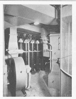
Abb. 15. Maschinenraum einer Kreislauflüftung. a Ventilator, b Sauerstofflaschen, c Kohlensäureabsorptionsapparat, d Pumpen zum Umwälzen der Kalilauge, e Feuchtigkeitsregulierapparat, f Luftkühlanlage
