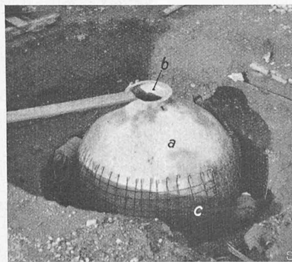
Abb. 3 (links). Guniterschalen in der Werkstatt. a Schale für die Eingangspartie, b Gucköffnungen, c Schiessöffnungen, d Rahmen für die Panzertüre, e Notausgang, f Schale für den eigentlichen Schutzraum, g Einsteigöffnung, h Montagehaken zum Versetzen
