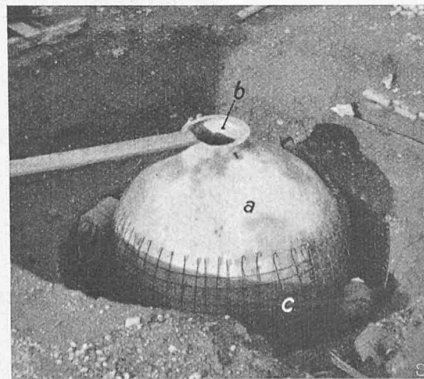
Abb. 3 (links). Guniteschalen in der Werkstatt. a Schale für die Eingangspartie, b Gucköffnungen, c Schiessöffnungen, d Rahmen für die Panzertüre, e Notausgang, f Schale für den eigentlichen Schutzraum, g Einsteigöffnung, h Montagehaken zum Versetzen
