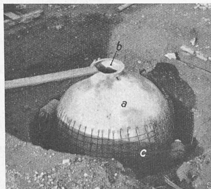
Abb. 3 (links). Gunitischen Schalen in der Werkstatt. a Schale für die Eingangspartie, b Gucköffnungen, c Schiessöffnungen, d Rahmen für die Panzertüre, e Notausgang, f Schale für den eigentlichen Schutzraum, g Einsteigöffnung, h Montagehaken zum Versetzen
