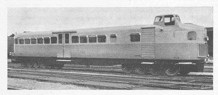
Abb. 1. Normalspur-«Micheline», 250 PS Benzinmotor; Tara 10 t, 56 Sitze = 179 kg/Sitz
