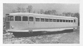
Abb. 4. Meterspur-«Micheline» mit Benzinmotor; 46 Sitzplätze
