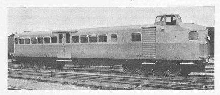
Abb. 1. Normalspur-«Micheline», 250 PS Benzinmotor; Tara 10 t, 56 Sitze = 179 kg/Sitz
