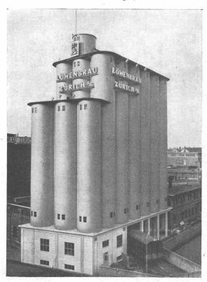
Fundation und Silounterbau in Eisenbeton:
