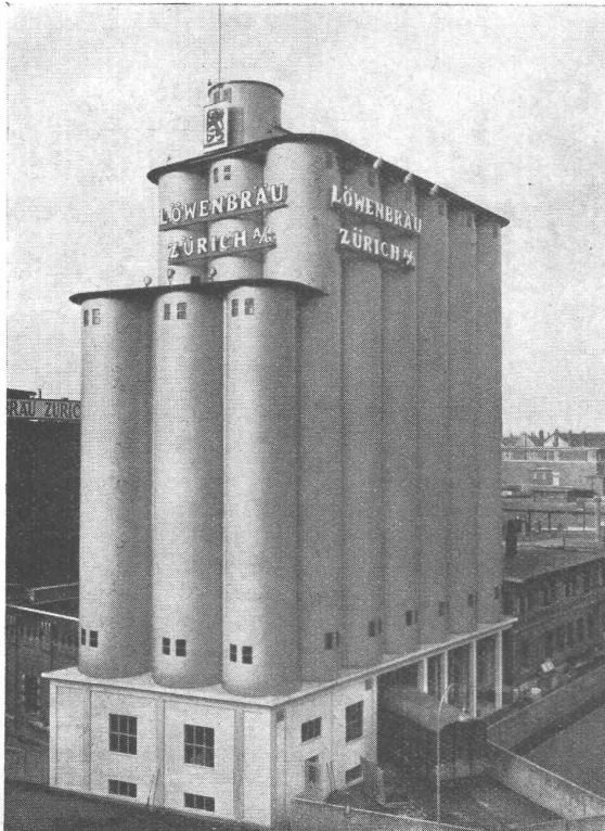
Fundation und Silounterbau in Eisenbeton: Ed. Züblin & Cie., A.-G., Zürich
