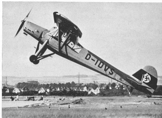
Abb. 1. Der «Storch» Gerhard Fieslers beim Start, Argus-Motor 240 PS.
