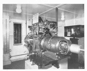
Abb. 4. Antriebswinde des Lifts, links der Standortsanzeiger
